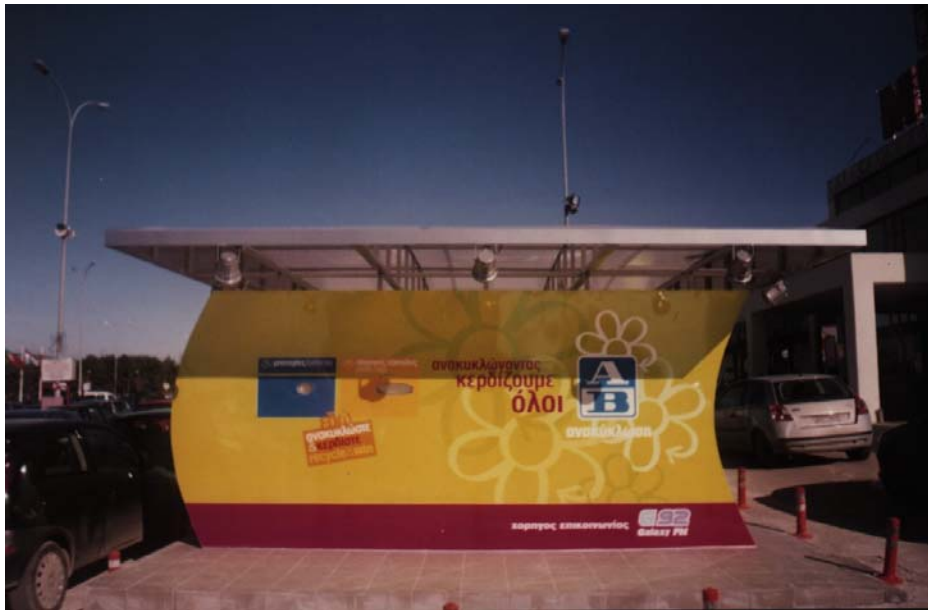
Πλάγια όψη Ολοκληρωμένου Κέντρου Ανακύκλωσης MEGA Εθνικής
